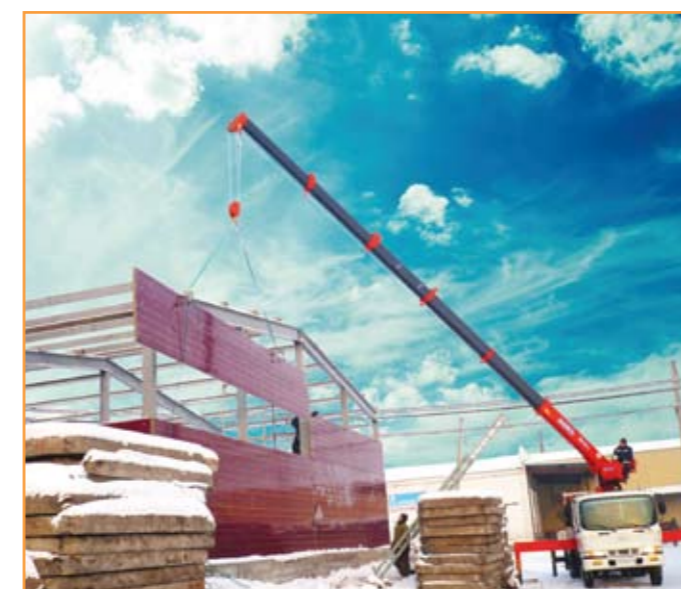
Строительство модульных зданий
