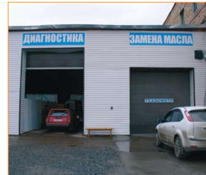
Пункт замены масла
