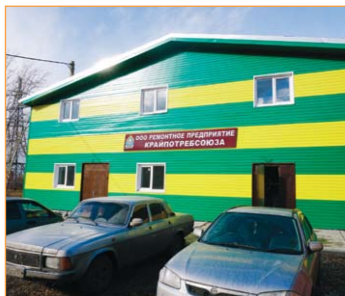
Фасад здания ООО «Ремонтное предприятие крайпотребсоюза»
